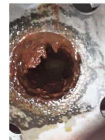
Verniz nas tubulações de óleo
